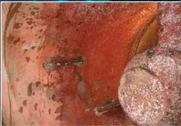
Corrosión alrededor del propulsor de proa.
